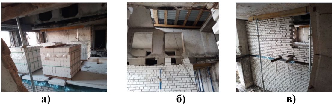
Рисунок 6– Відновлення конструкцій внутрішніх стін:
